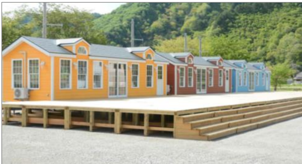
亀岡トレーラーハウス【外観】
