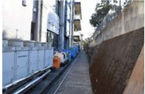
写真 この狭い通路をラックで運搬しなければならない
