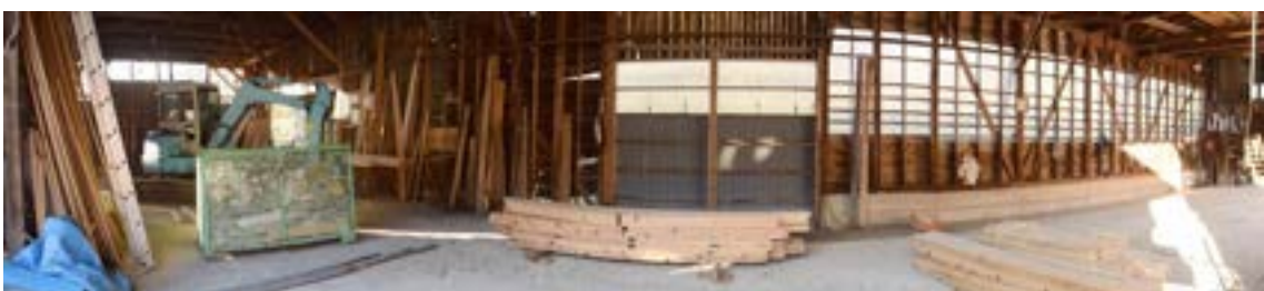
写真 11 内部(加工室南より)
