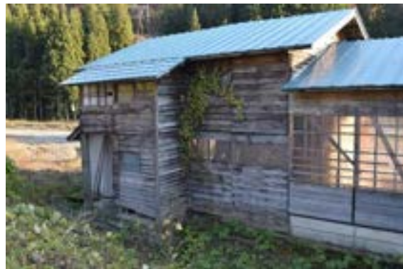
写真 5 北側外観(西より)
