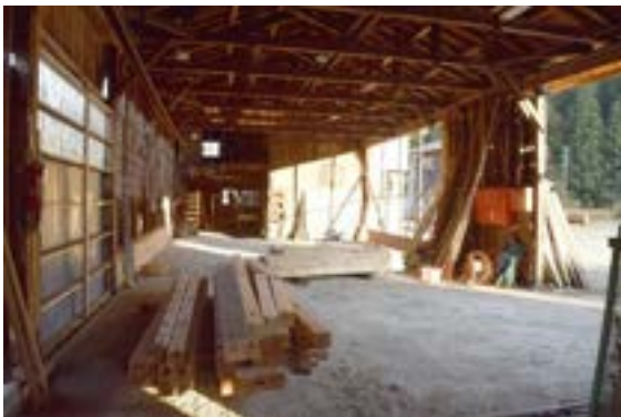
写真 7 内部(加工室西より)
