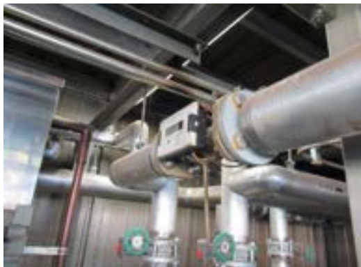
写真 発熱量を計るメーターがついている。
