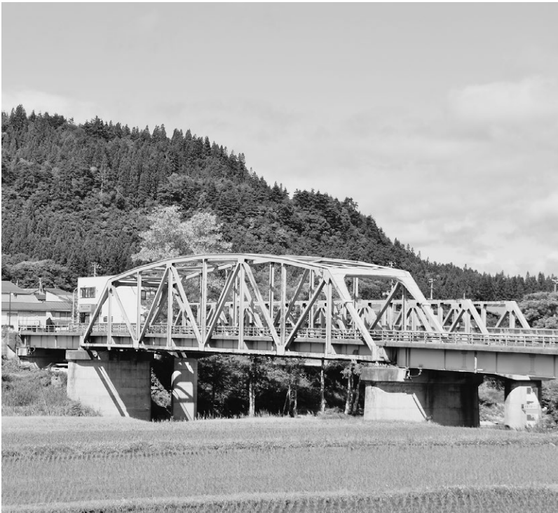
八十里越開通までに改良が必要な明和橋
