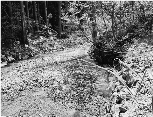
取水堰に溜まった土砂
