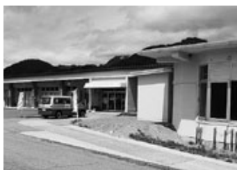
保養センターの外観
