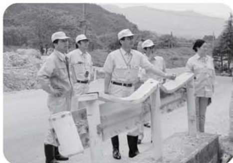
災害箇所を視察
