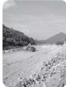
堤防を造成中
