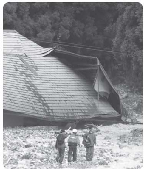
土砂は建物を飲み込む。避難施設は…
