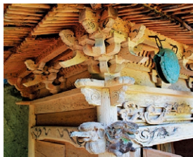
▲虚空蔵堂の二重垂木・組物・彫物
