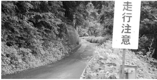
▲ 道路改良要望区間(1.3km)
