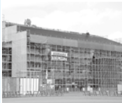
▲建設中の只見小学校体育館
