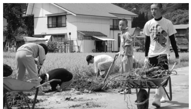
▲側溝の土砂を撤去する只見高校生
