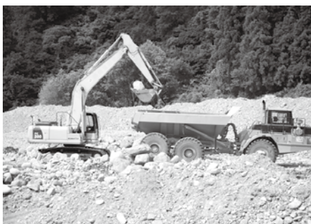
▲町内全域で進む復旧工事
