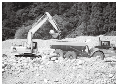
▲町内全域で進む復旧工事
