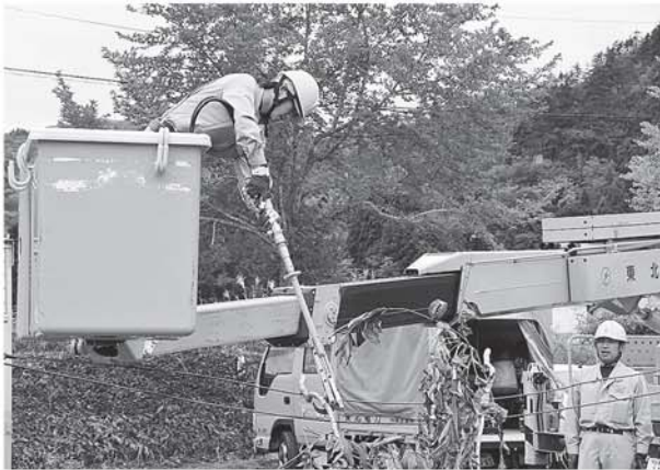
▲東北電力による応急復旧作業訓練
