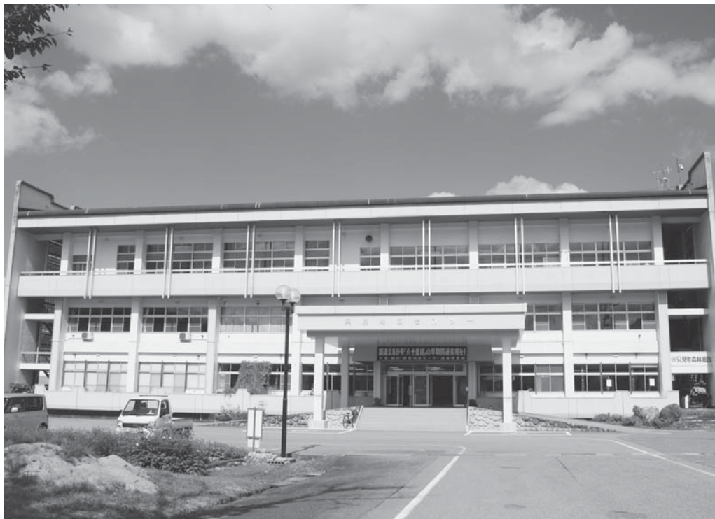
▲平成26年度に取り壊された只見総合開発センター
