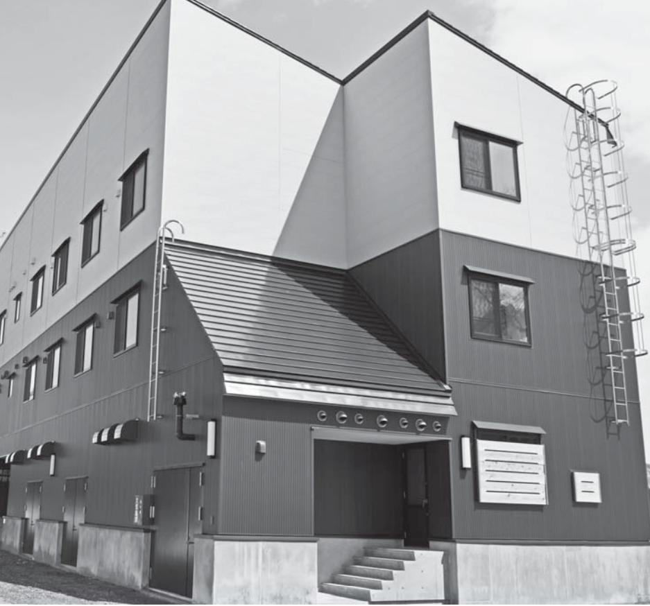
▲3月23日に竣工した奥会津学習センター
