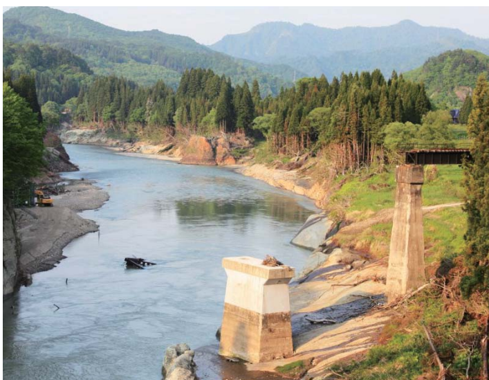
▲第7只見川橋梁(金山町)【橋げた流失】
