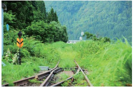
上／6年間列車がなくなった会津蒲生駅 下／廃線跡のように草に覆われた線路
