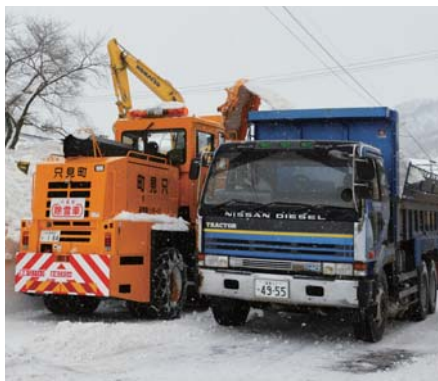
▲町内各地から雪を集める現場
