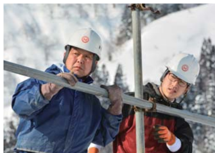
▲小間の高さや角度を確認しながら作業を進める現場
