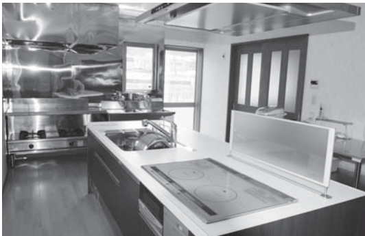
▲原材料の保管・商品の加工・パッケージなど作業が行える加工施設
