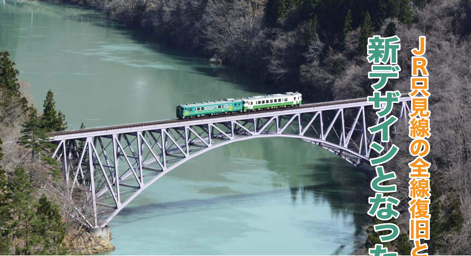
▲三島町の第一只見川橋梁を走るラッピング列車
