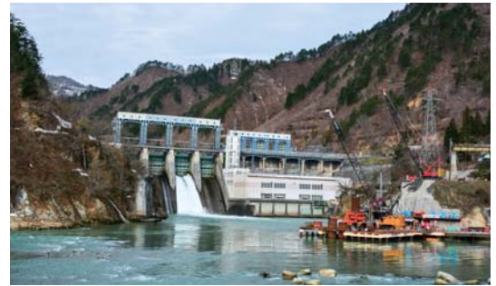
▲今年度から不通区間の復旧工事が始まる現場(第六只見川橋梁・金山町)
