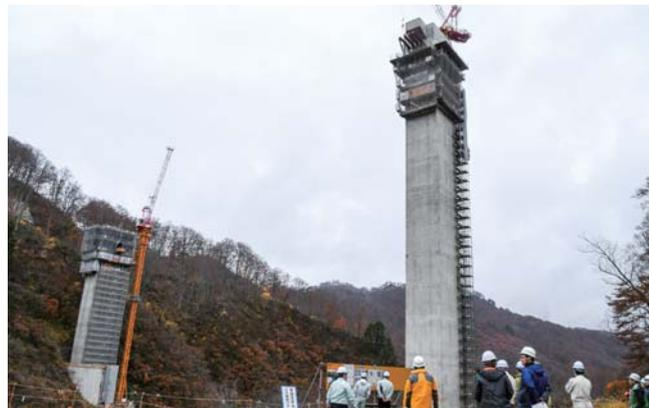
▲三条市側、最大で高さ 80m を超える国内トップクラスの橋脚を誇る5号橋梁(長さ 337m)の工事現場
