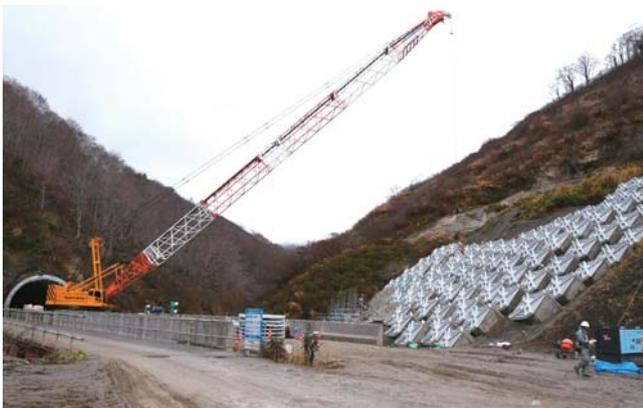
▲只見町側・7号橋梁(33m)、土砂流出を防ぐための工事を進める現場
