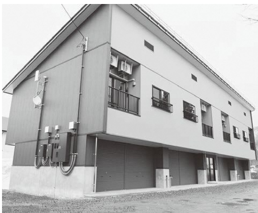
▲竣工した定住促進住宅・沖住宅
