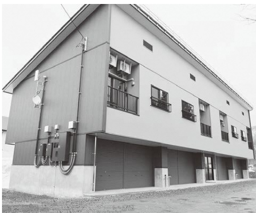
▲竣工した定住促進住宅・沖住宅
