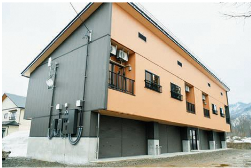
▲今年3月に竣工した「只見町定住促進住宅・沖住宅」
