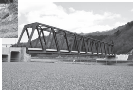
▼4/1に開通した万代橋
