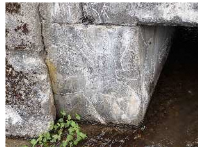
167. 別当沢橋： RC床版橋+ボックスカルバート橋 (橋長：3.80m、1975年竣工) 橋台前・側面の遊離石灰を伴うひびわれ ※雨水の浸入により、進行する可能性が高い。(迂回路有り)
