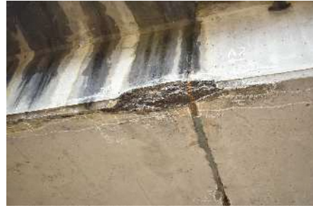
42. 沖の原橋：ポステン箱桁橋 (橋長：17.00m、1970年竣工) ポステン桁下面の剥離、遊離石灰 ※雨水の浸入により、進行する可能性が高い。(迂回路無し)
