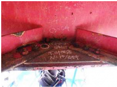
35. 芦沢橋：鋼I桁橋 (橋長：28.00m、1984年竣工) 横構格点部のボルト脱落 ※ボルトの脱落により、主要部材への影響も懸念される。(迂回路有り)
