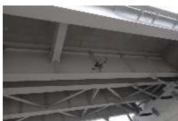
ドローンによる桁下の点検
