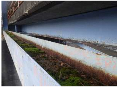
22. 柴倉橋：鋼トラス橋+鋼I桁橋 (橋長：100.00m、1973年竣工) トラス上・下弦材の板厚減少 ※腐食の進行による板厚減少により、耐荷力の低下が推測される。(迂回路有り)
